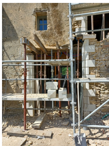
Création ouverture porte d'entrée
