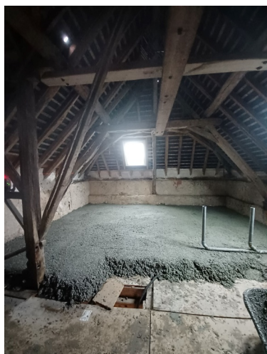
Dalle chaux chanvre au 2 ème étage
