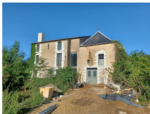
Façade après travaux
